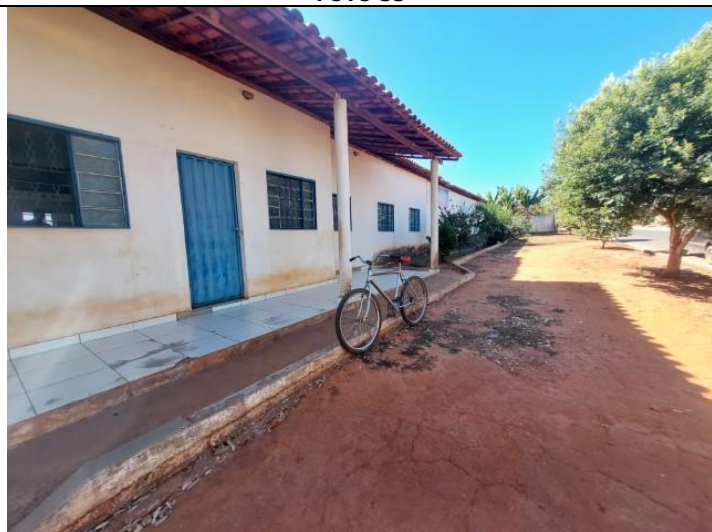
Descrição: Entrada da edificação
