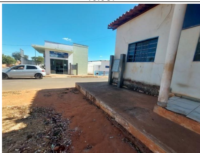
Descrição: : Entrada da edificação
