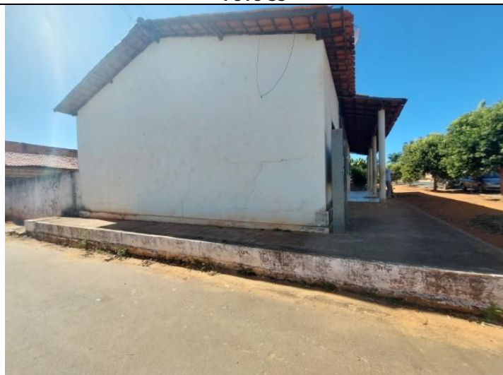
Descrição: : Entrada da edificação
