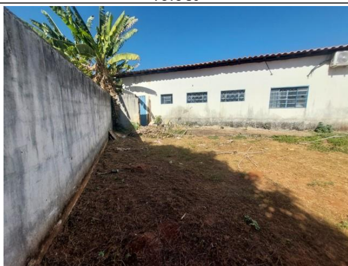
Descrição: Lateral da edificação
